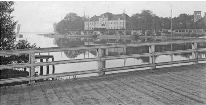
Blick von der alten Holzbrücke auf das Schloss
