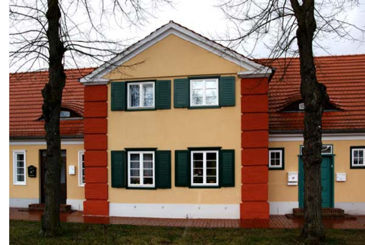
Hausfassade Mitte des Platzes
