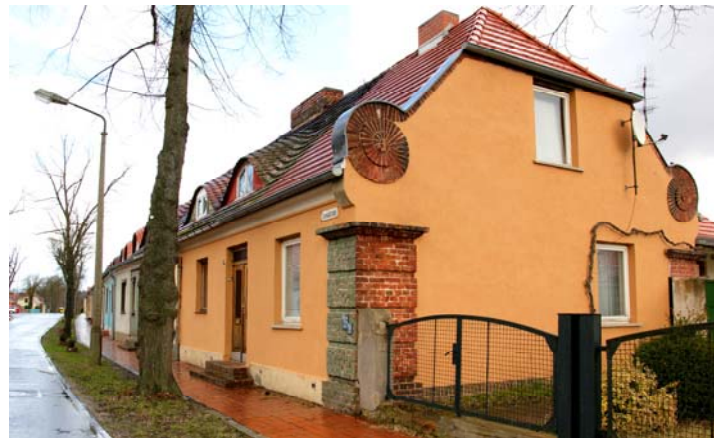
Eingangshaus mit gemauerten Voluten
