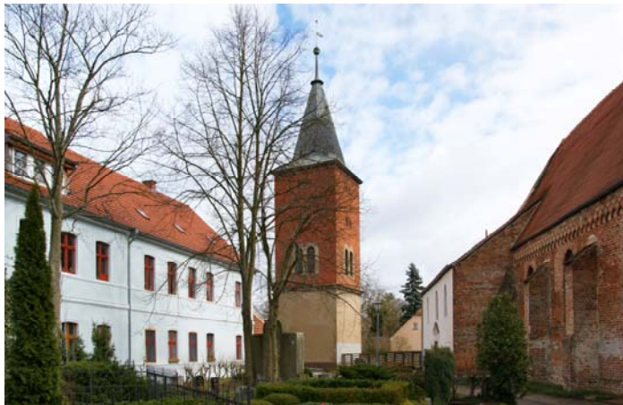
Blick auf das Ensemble Alte Schule, Turm, Kirche Nordseite, Kriegerdenkmal
