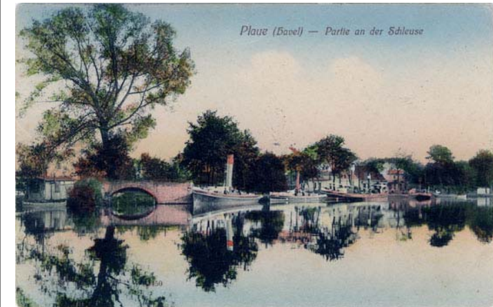
Schleusenvorhafen mit Mastenkranlage (1821-23) und Gaststätte Dorotheenhof, Postkarte um 1910
