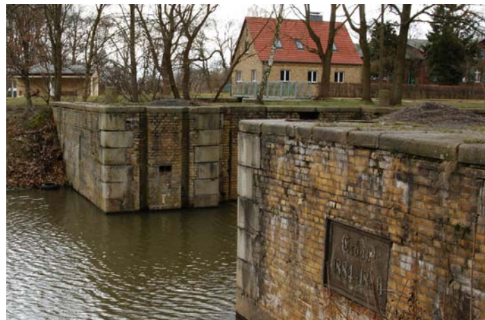
Ausgang der nördlichen Schleusenkammer zum Plauer See
