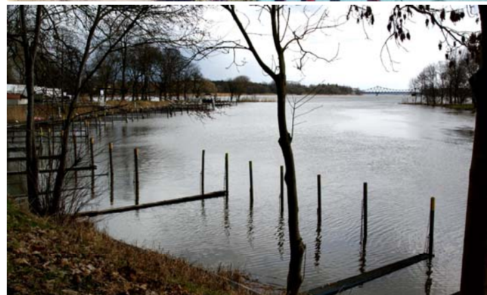
Partie an der Schleuse 1911 und 2009
