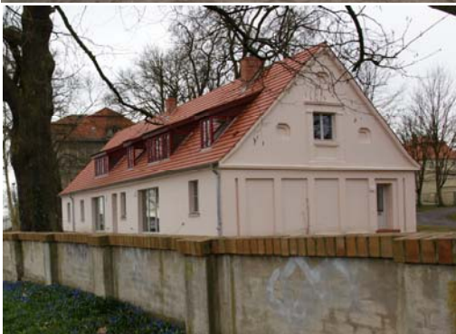
Restaurierte Nebengebäude (Situation 2009); oben Kopfgebäude Nordtrakt, unten Fischerhaus
